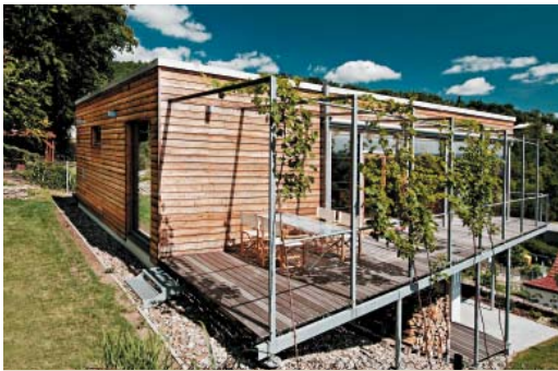
Šetrné bydlení u lesa ve městě / Hana Urbášková. Rodinný dům postavený v nepříznivých podmínkách s nízkými pořizovacími náklady, energeticky šetrným provozem, minimalizací tepelných ztrát a zdravým vnitřním prostředím
