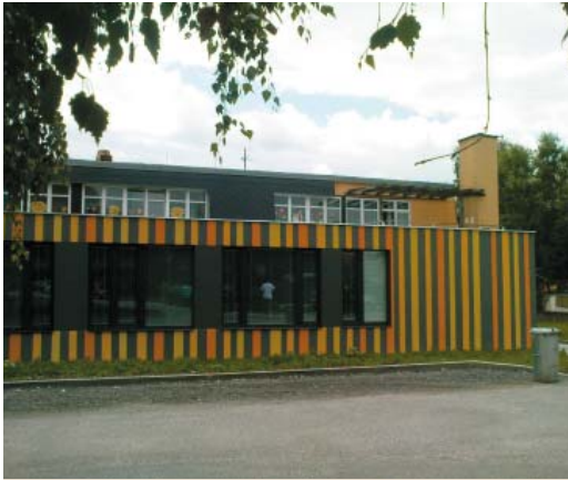
Změna topného systému MŠ Kamenný Újezd / obec Kamenný Újezd. Odpad z vlastní pily obce slouží k vytápění základní školy, mateřské školy i domu s pečovatelskou službou
