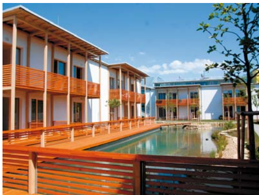
Pasivní bytový dům pro seniory Modřice / město Modřice. Největší pasivní stavba v ČR postavená a financovaná municipalitou
